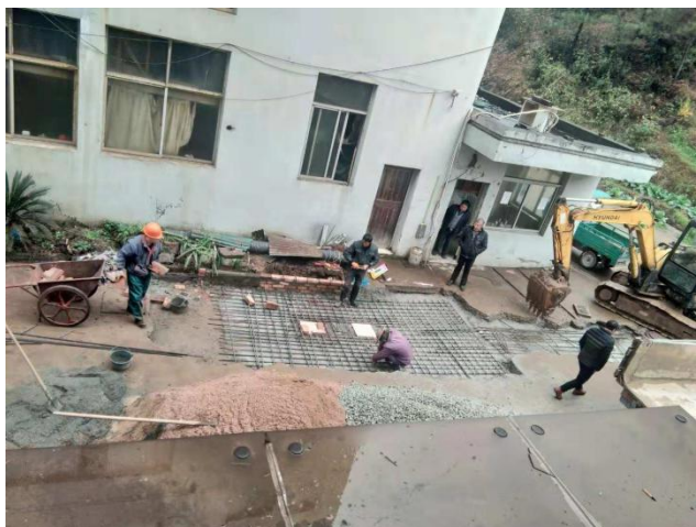
图 2.3-1 生活污水纳管设施建设
