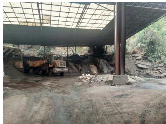
图 2.5-4 2#车间固废堆场
