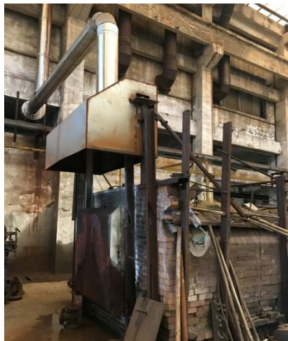
图 2.5-2 烧模壳烟尘收集集气罩
